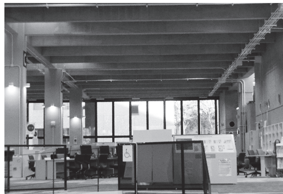
写真12 玄関から階段があるが、東側から西側まで間仕切りはなく、メインエリアはフラットである。
