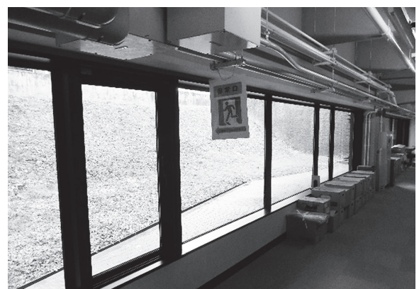
写真11 地下1階西側窓 地下書庫まで光を入れたかったのだから
