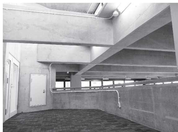
写真7 館内各所に見られるコンクリート打ちっぱなし
