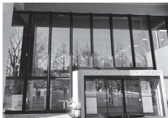
写真13 玄関：利用者用は1つだけ設けられ、地面に対してはフラットである。
