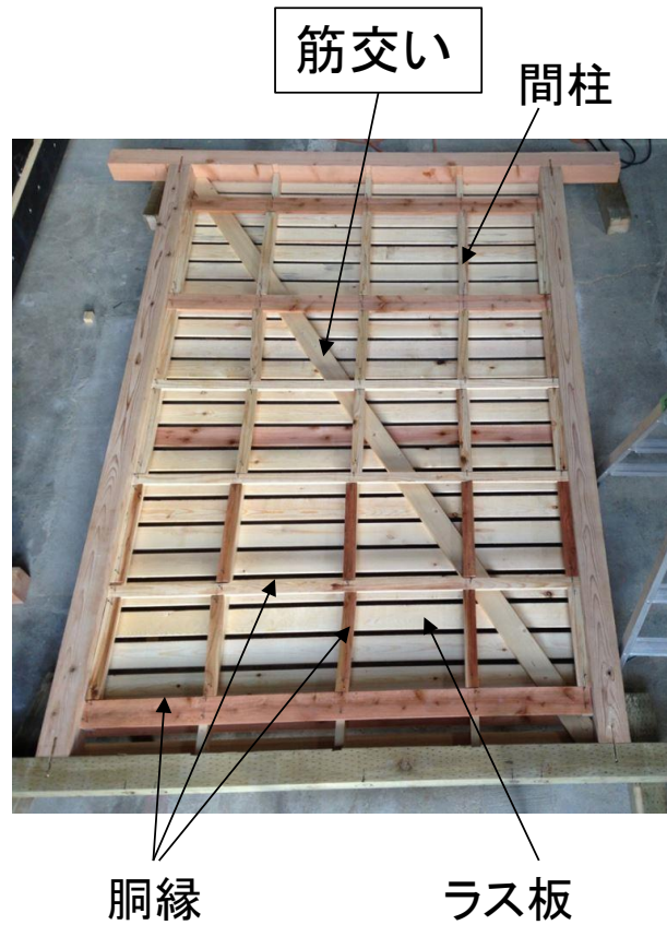
従来工法木造家屋の外壁を再現した試験体 No. 1 の内部構造（屋内側から）
