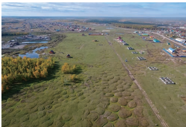
Подземный грунт (бывшая взлетно-посадочная полоса), затронутый таянием вечной мерзлоты в с. Чурапча. (Фото А. Фёдорова, 2017 год)
