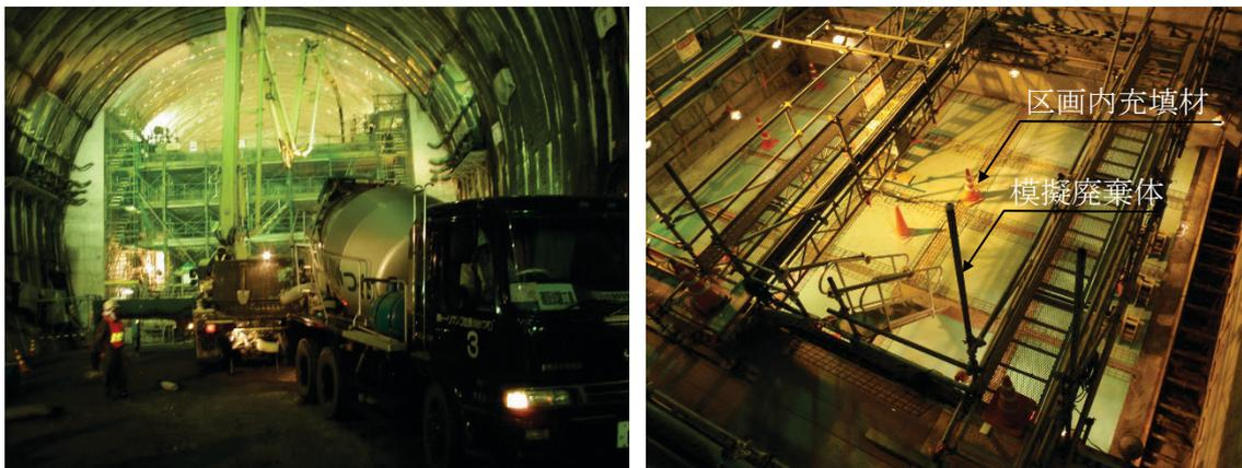
写真 6-1 ポンプ方式の施工状況と打込み箇所全景
