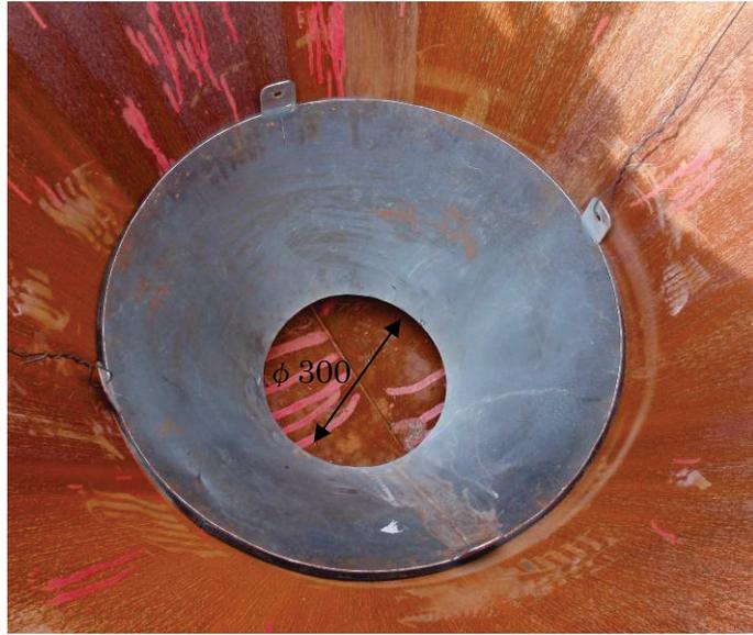
写真 2-1 排出口調整金物（排出口  $\phi 300$  mm）
