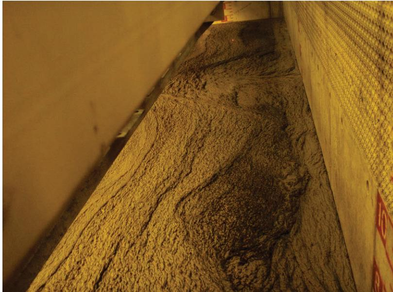
写真 6-11 コンクリート表面のこわばり
