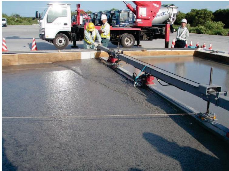
写真 2-5 表面均し装置施工状況
