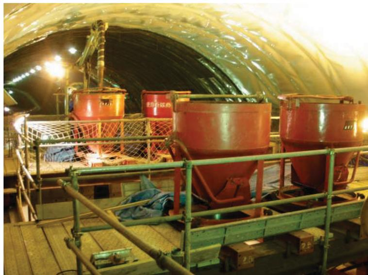
写真 6-2 バケット方式の打込み状況
