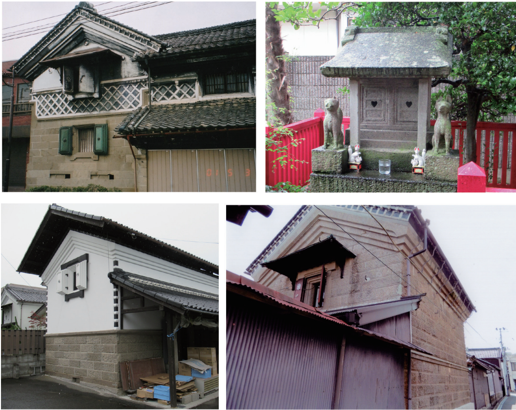
図 10 富沢石の建築 (上左) 旧高橋養吉商店袖蔵 積石 現存せず (図版提供：千葉宗久氏) (上右) 旧高橋養吉商店邸内社 (下左) 旧松浦呉服店石蔵 積石 (図版提供：竹駒神社) (下右) 旧岡崎文助商店石蔵 張石
