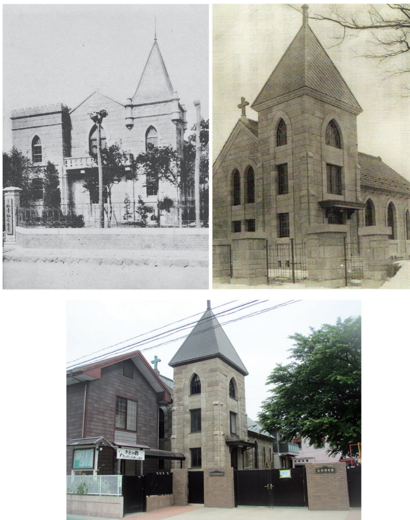
図 11 石材を用いた教会 (上左) 仙台組合教会 (図版:『秋保石材軌道株式会社』より) (上右) 竣工時の岩沼教会 (図版提供:岩沼教会) (下) 現在の岩沼教会
