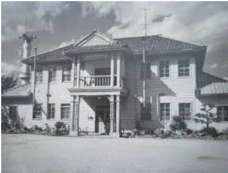
写真5 旧刈田病院本館（明治15年宮城病院白石分院本館として建設、白石市教育委員会提供）
