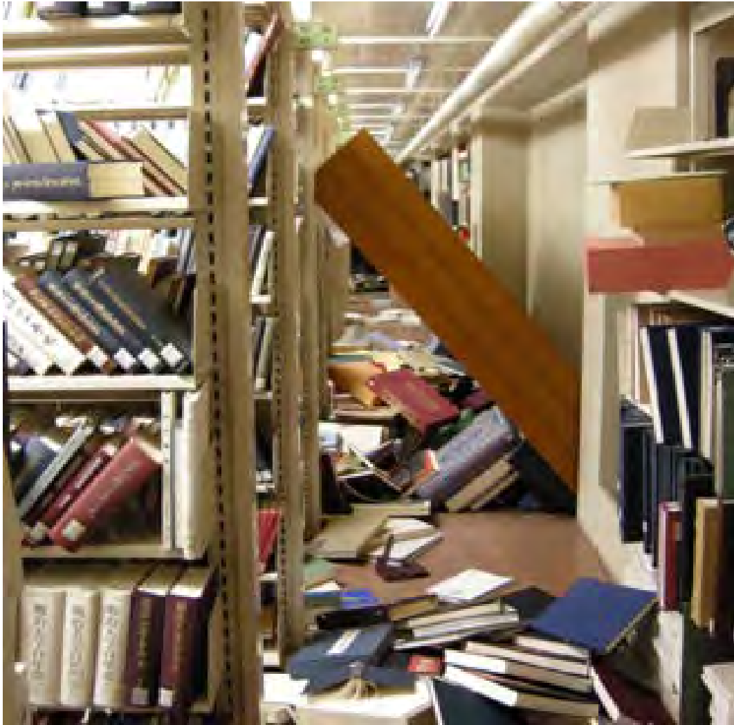
本館1号館 地下2階書庫
