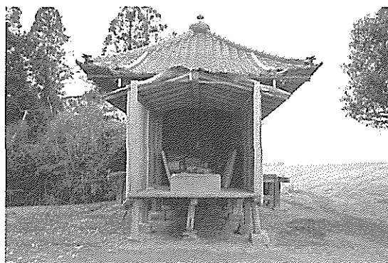
写真 拝殿が倒壊した日月堂
