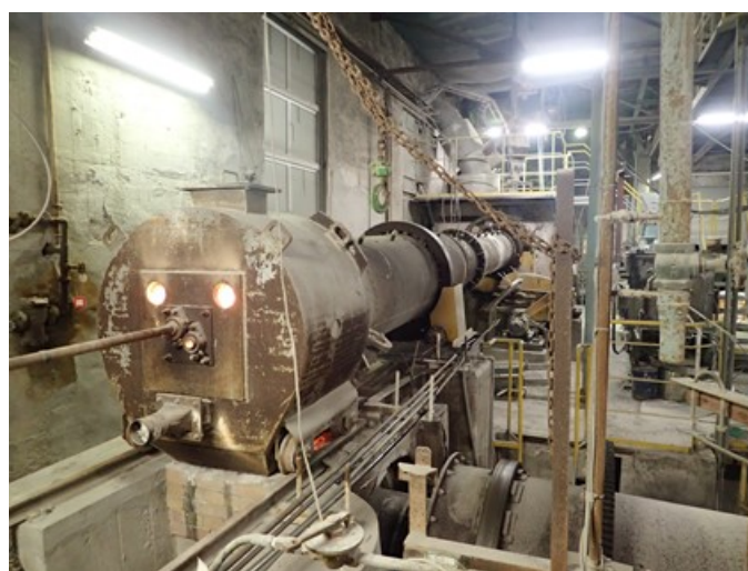
図-3.7 1号キルンの外観
