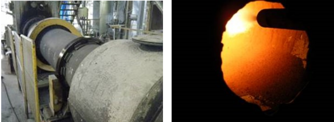
図-3.5 5号キルンの外観およびキルン内の様子
