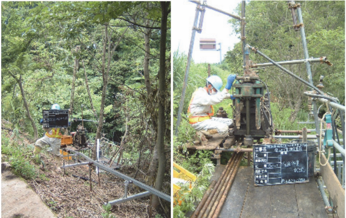
写真 6-2 ボーリング調査状況写真（左：全景・モノレール，右：掘削状況）
