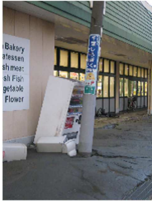
写真 1.9 液状化による被害（千葉県千葉市）
