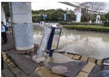
写真 1.8 液状化による被害（千葉県浦安市）
