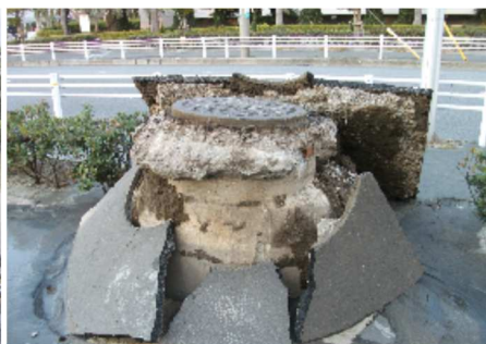
写真 1.8 液状化による被害（千葉県浦安市）
