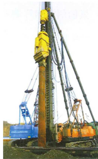
写真 1.3 中掘り根固め工法 1,4)
