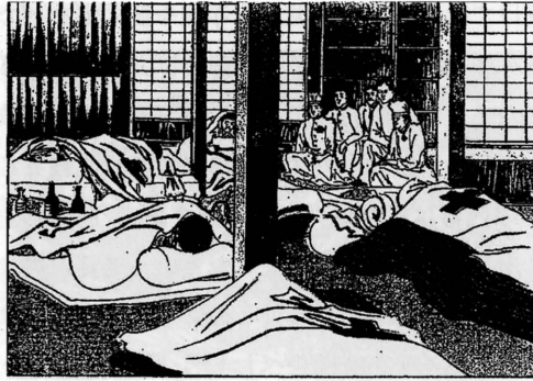
(図2-2) 仮病院として使用される寺院 『日本赤十字社宮城支部海嘯救護記事』より
