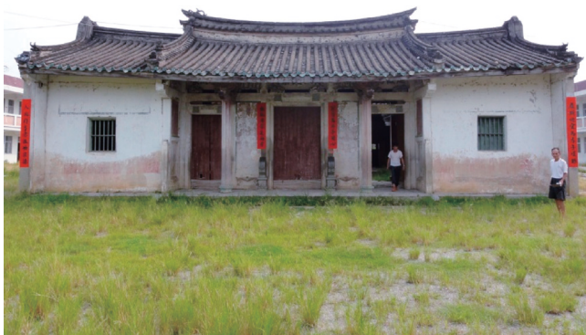
写真3 C村祠堂の外観
