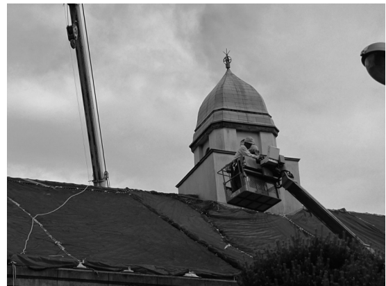
写真3 屋根へのブルーシートかけ
