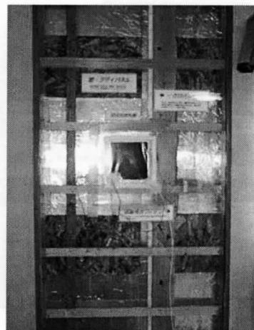
写真3-8-6 居間壁体内の様子
