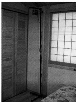
写真 3-8-36 攪拌用の小型 ファン (子供室)
