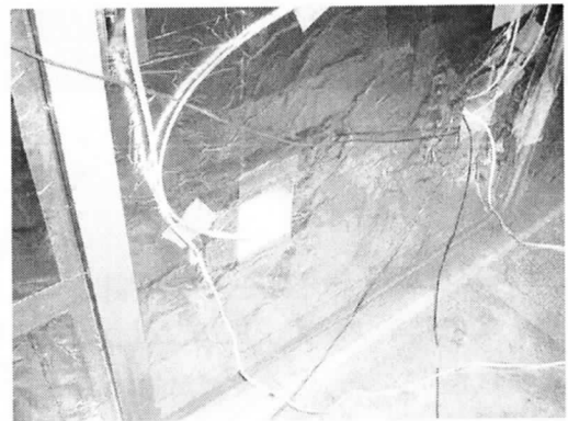
写真3-8-77 通気口のガス濃度測定点
