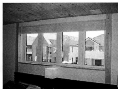
写真 2-4-5 窓（寝室） （左端の窓に測定器を設置）
