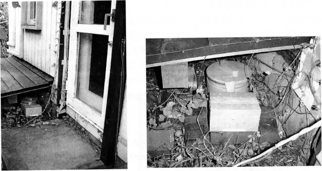
写真 3-8-82 外気側チューブの設置状況
