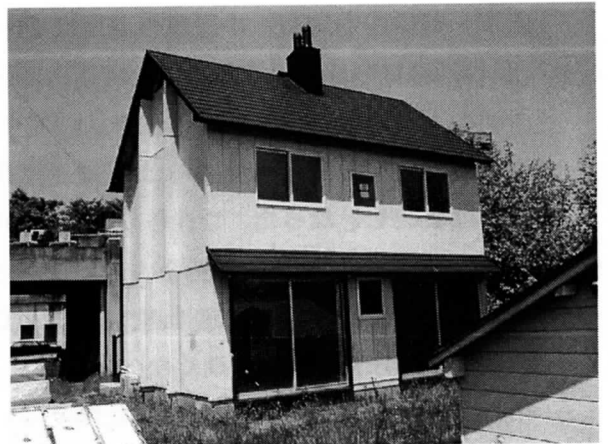
写真 3-8-53 実験家屋の外観
