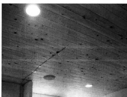
写真 3-8-52 天井面の表面温度（居間）
