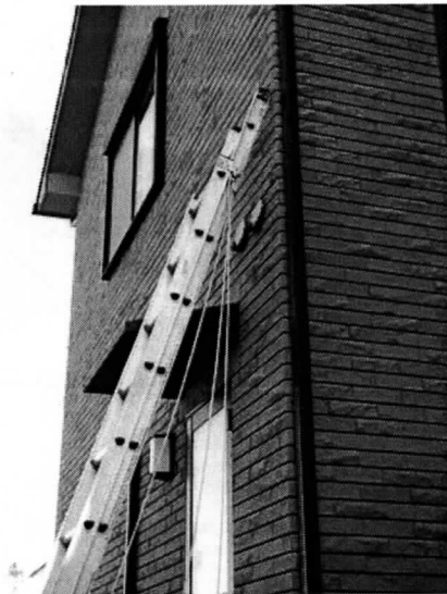
写真3-8-2 外気取り入れ口
