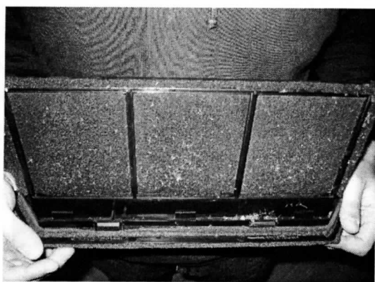
写真 3-5-13 給気側フィルター (住宅 H、熱交換ユニットに内臓)
