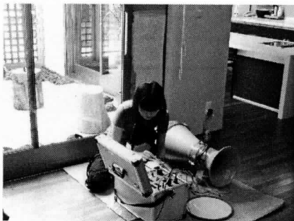
写真 2.4.9 相当隙間面積の測定
