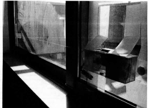
写真 3.7.5 窓開巾の測定 (2 階バルコニー)
