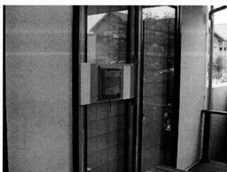
写真 4-5-45 風圧板 (ウッドデッキ・食堂側の窓)
