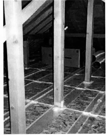
写真3-8-9 断熱気密層の外側の様子（西側）
