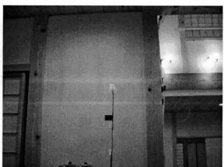
写真 3-8-51 壁面の表面温度（居間）
