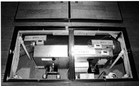
写真3-8-4 空気循環ユニットの設置状況とフィルター
