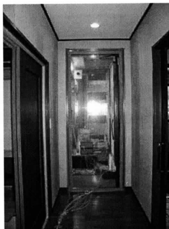
写真3-8-22 倉庫ドアのシール
