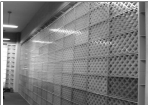
〔閲覧室〕 FRP ブロック耐震壁 (繊維強化プラスチックブロック)
