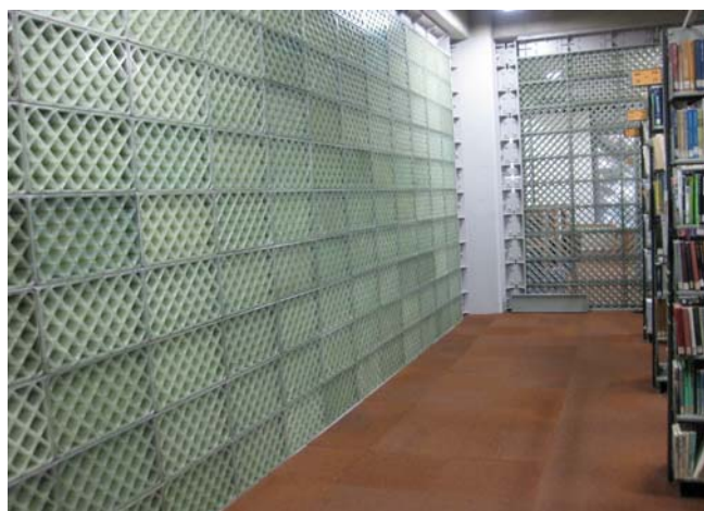
◇ FRPブロック耐震壁 (ガラス繊維強化プラスチック)
