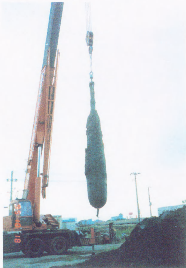
写真-3.2 クレーンによる凍結土柱の抜き上げ
