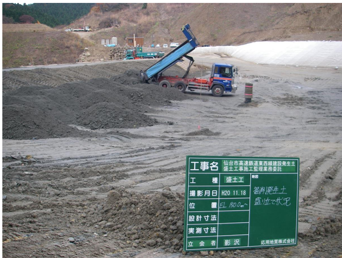
図 4.3.4 地下鉄工事における掘削発生土の粒径（こぶし大の岩石が多量に含まれる）
